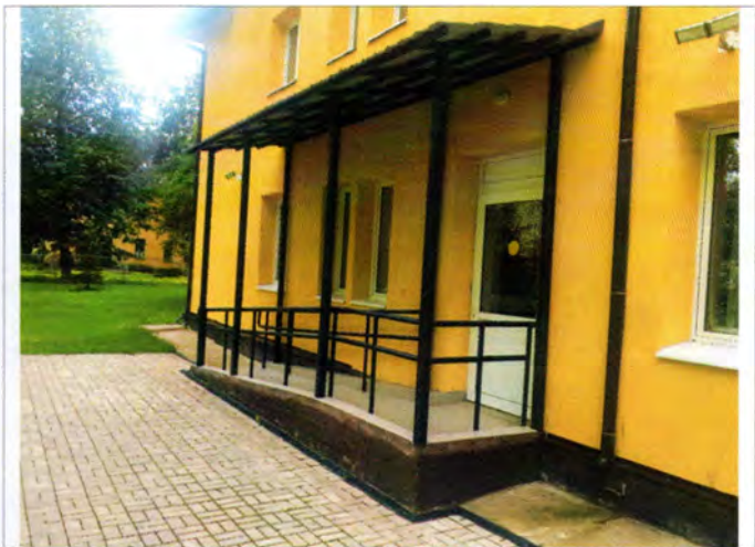
Фото №7 – Вход оборудованный пандусом.
