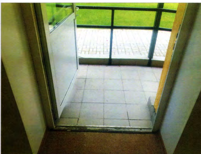
Фото №9 – Вход оборудованный пандусом.
