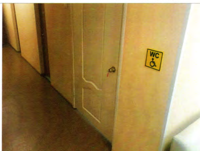
Фото №28 - Санитарно-гигиенические помещения.
