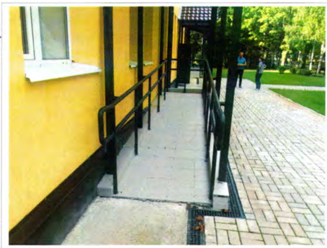
Фото №8 – Вход оборудованный пандусом.
