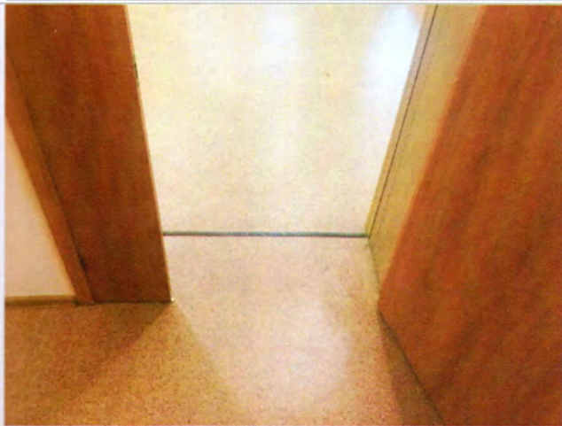
Фото №21 – Пути движения внутри здания (Двери)
