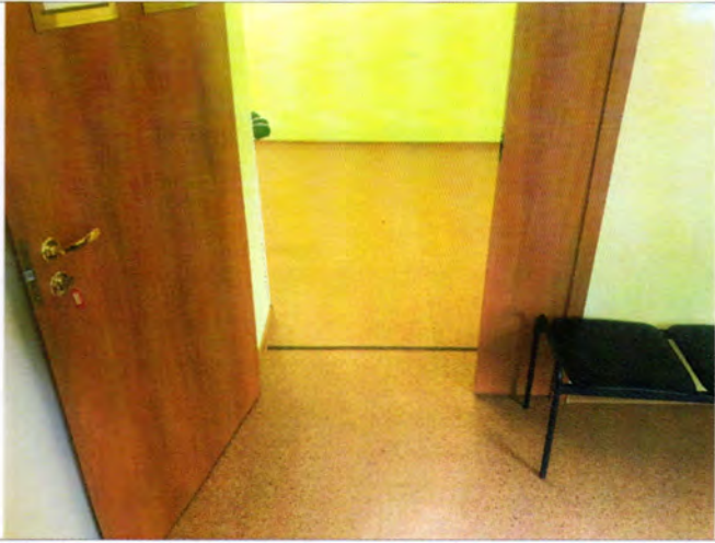
Фото №19 – Пути движения внутри здания (Двери)
