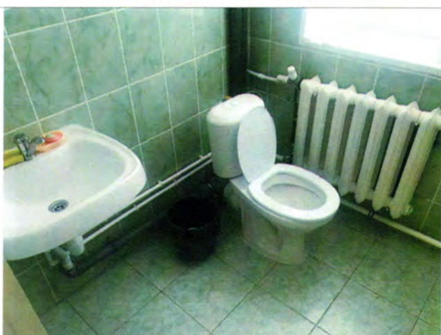
Фото №30 – Санитарно-гигиенические помещения.
