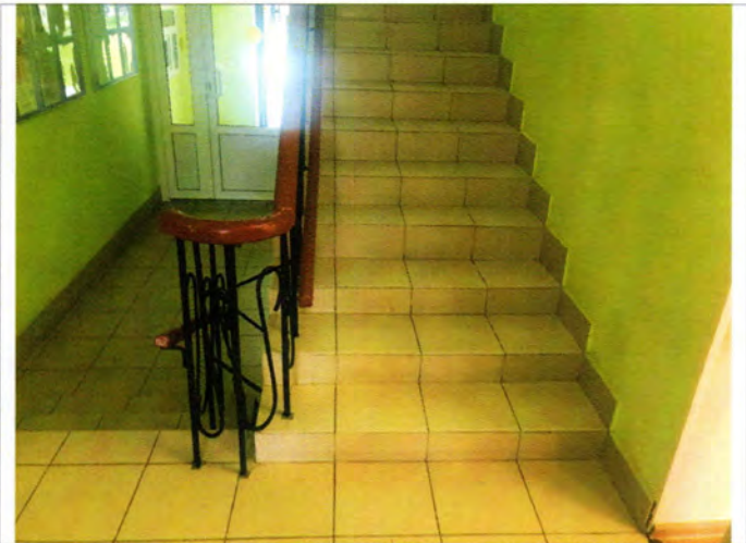
Фото №15 – Пути движения внутри здания (Лестницы)
