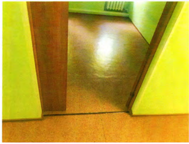
Фото №20 - Пути движения внутри здания (Двери)
